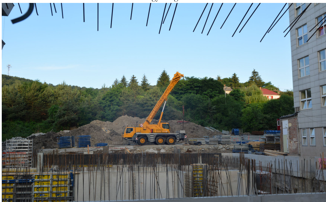
A falak elérték a talaj szintjét. Munkába állt egy kisegítő autódaru.
