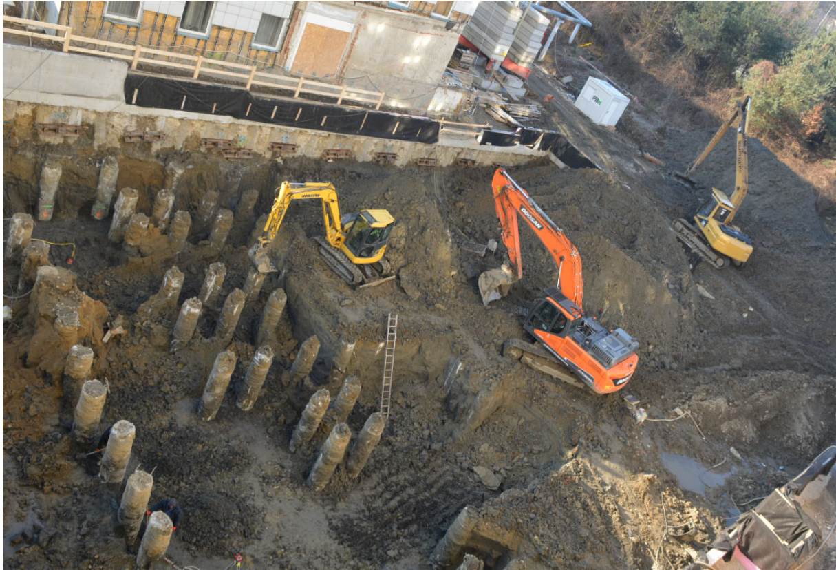
Csak több markoló, szintenként tudja kiemelni a földet a gödörből
