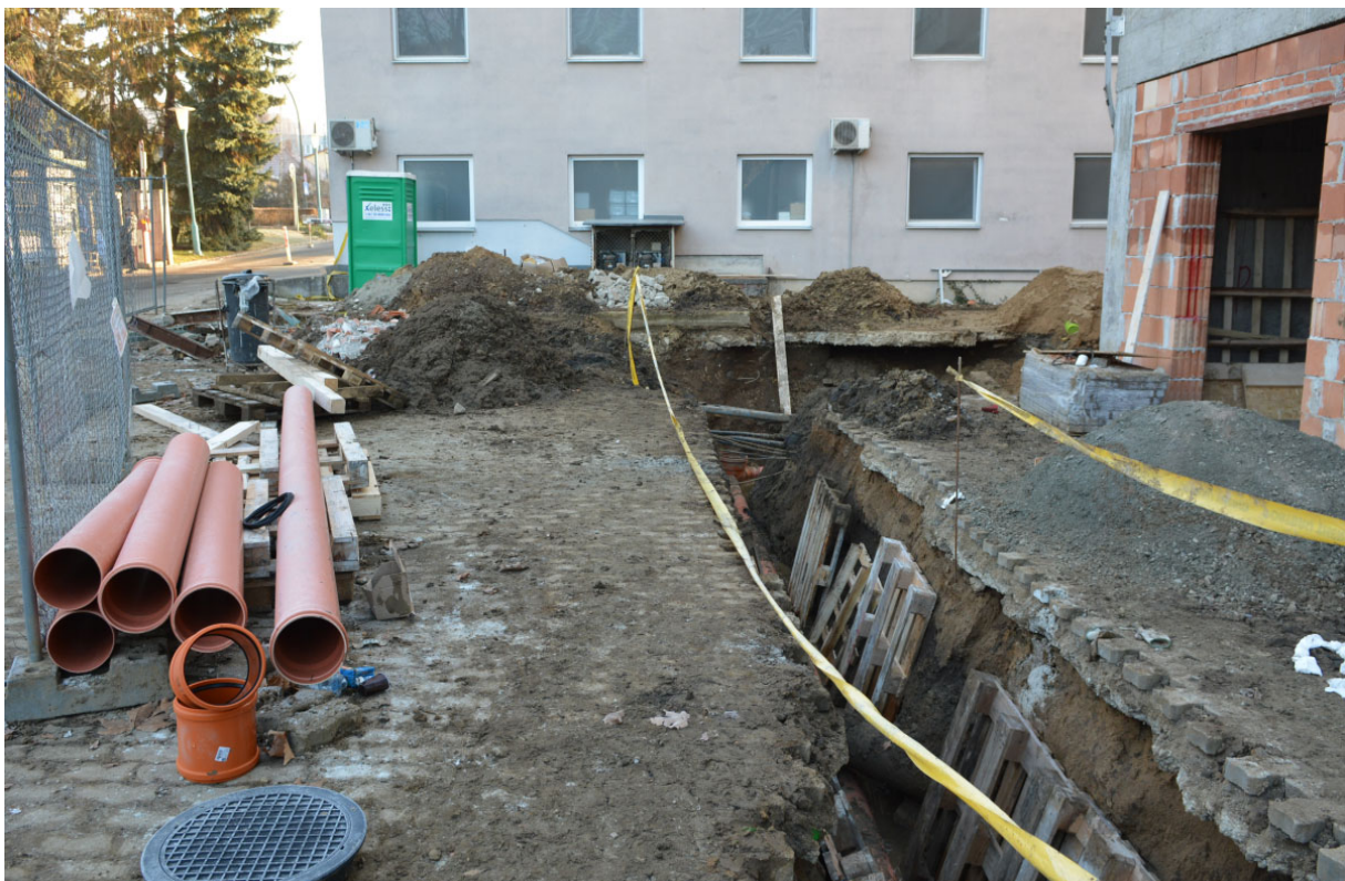
Helyükre kerülnek a csatornacsövek.
