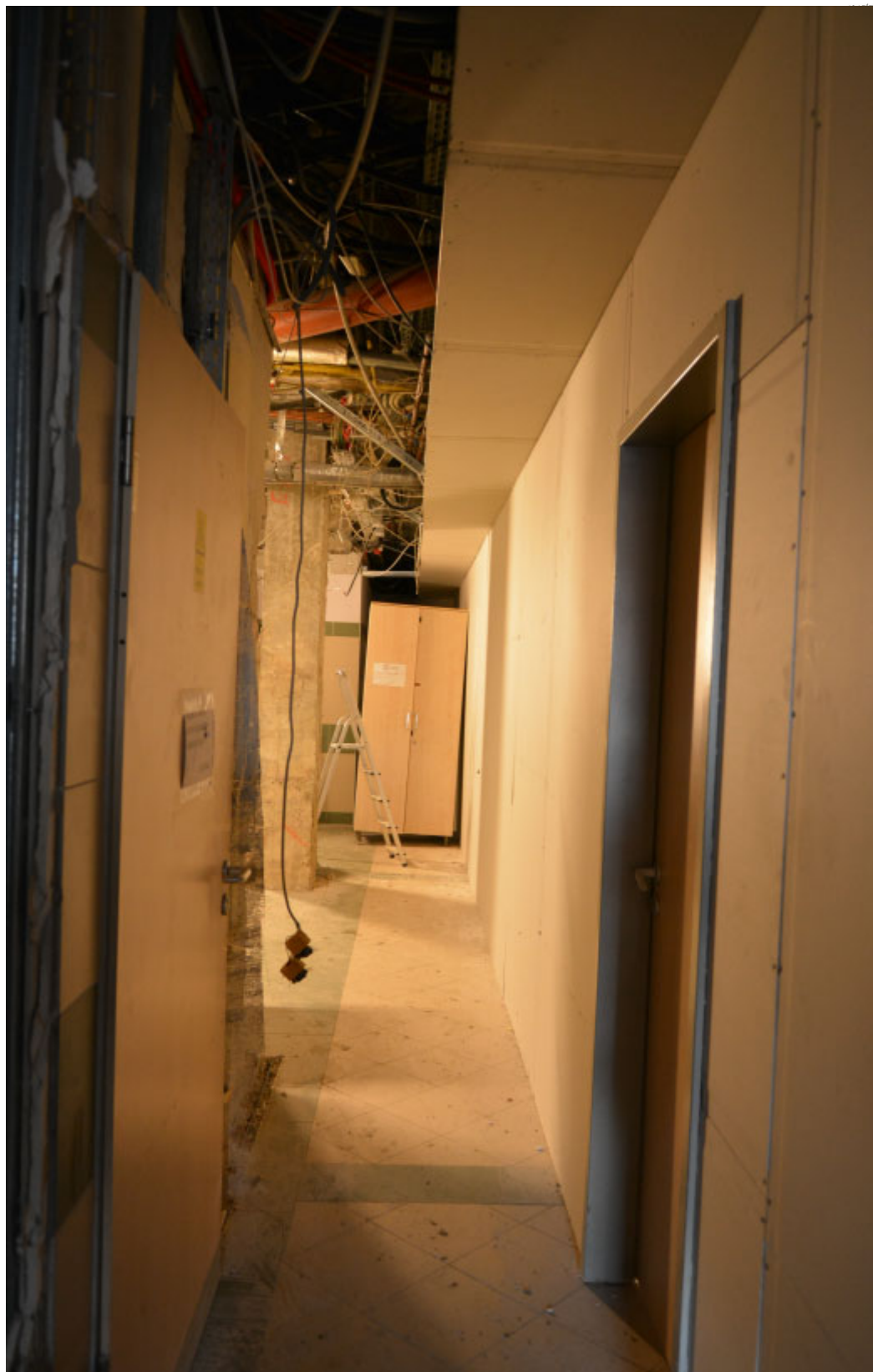
A SBO működő ellátó területét, jól szigetelt fal választja el a belső építési résztől.
